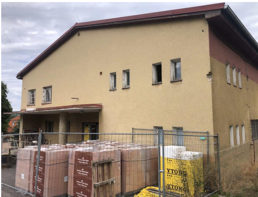
Zahájení rekonstrukce nového centrálního skladu potravinové banky.
